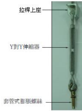
圖 4.4 拉桿組件裝設示意圖
